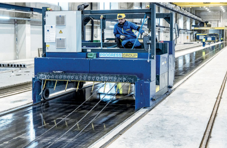
Многофункциональная тележка с аккумулятором используется для подготовки стенда: для очистки, смазки и натяжения канатов /провода натяжения
