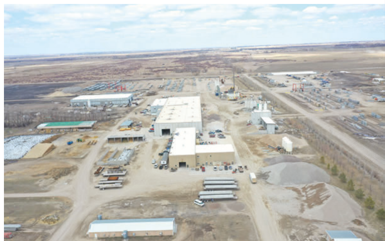
Taracon Precast ha modernizzato il proprio stabilimento con macchine e software del gruppo Progress.
