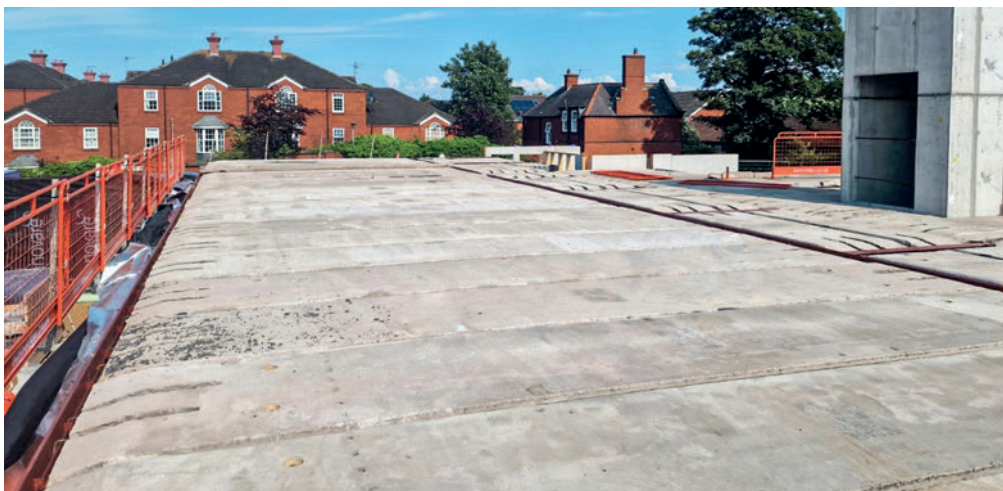
Die produzierten Spannbetonfertigdecken sind leicht, aber dennoch stabil genug für schwere Lasten.
